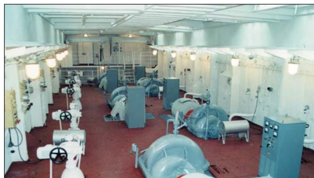
Плавучая насосная станция «Влага-1» и ее насосное отделение (ОАО «Волгоградский судостроительный завод»)
