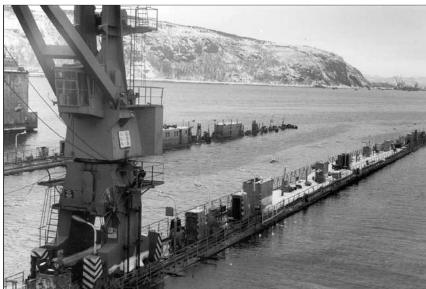
Рис. 1. Аварийное затопление плавучего дока
