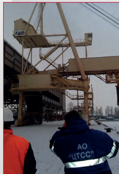
Рис. 8 Контроль положения при установке замененных элементов судопогрузочной стрелы
