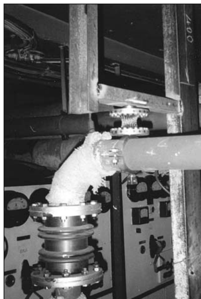
Рис. 6. Газоотвод дизель-генератора ДГА 50-9 с упругой подвеской — гиперболоидообразным виброизолятором
