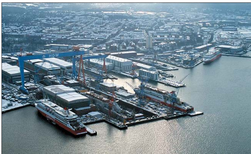
Немецкая верфь Howaldtswerke-Deutsche Werf AG использует при проектировании и постройке транспортных судов и военных кораблей компьютеризированную судостроительную систему Tribon Shipbuilding System
