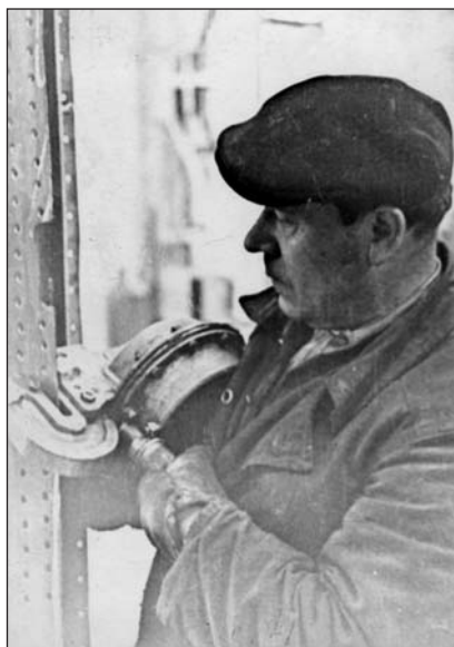
Рис. 1. Проколка отверстий в комингсах судовых дверей
