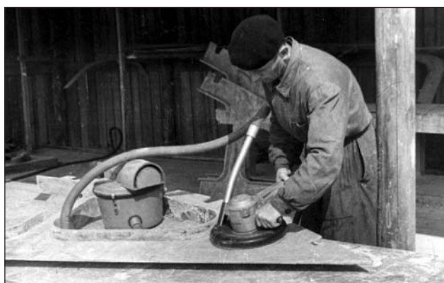
Зачистка поверхности стеклопластиковой конструкции пневмощеткой с отсосом стеклопыли
