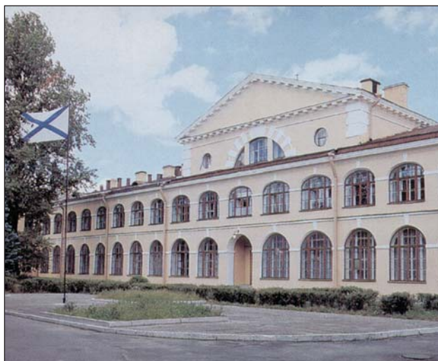
Здание 1 ЦНИИ МО РФ
