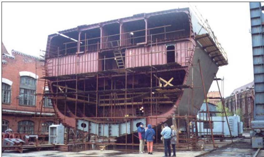
Блок корпуса корабля на предстапельной площадке ОАО «Балтийский завод»
