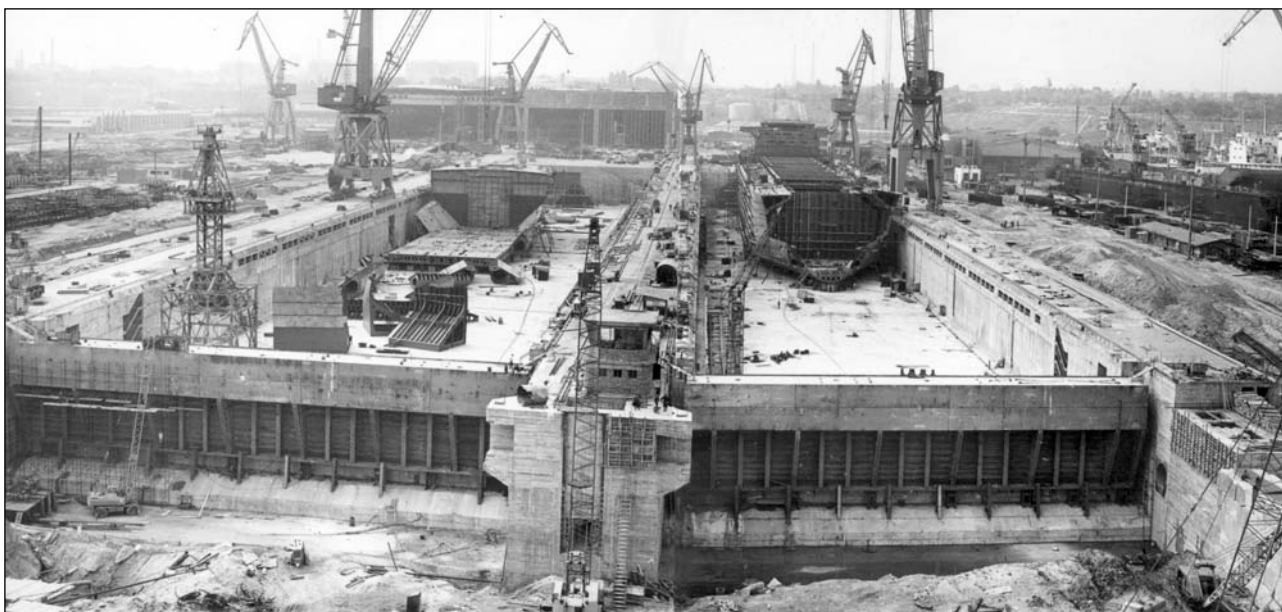
Панорама строительства по проекту ГСПИ «Союзпроектверфь» сухих доков в Констанце (1974 г.)
