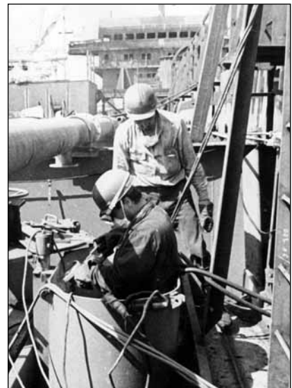
Рис. 3. Зачистка сварного шва, осуществляемая на палубе танкера с помощью электроинструмента на 220 В/50 Гц
