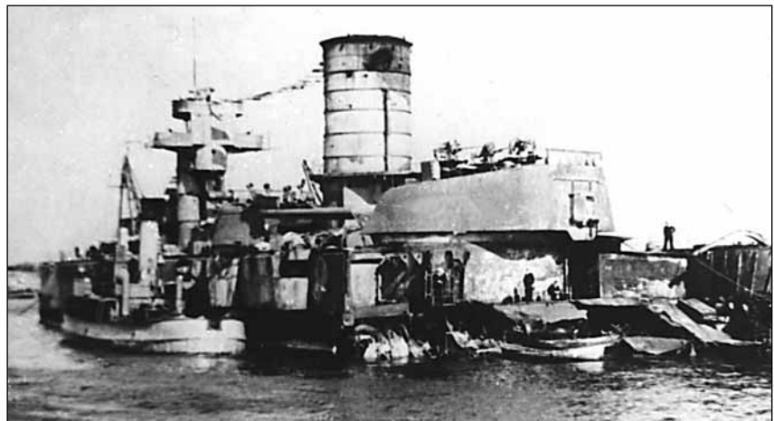
Восстановительный ремонт линкора «Марат»
