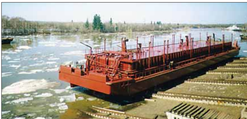
Спуск баржи пр. 81371 для перевозки нефтепродуктов, построенной ОАО «Самусьский судостроительно-судоремонтный завод»
