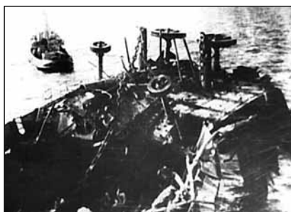
Повреждение носовой оконечности линкора «Октябрьская Революция»
