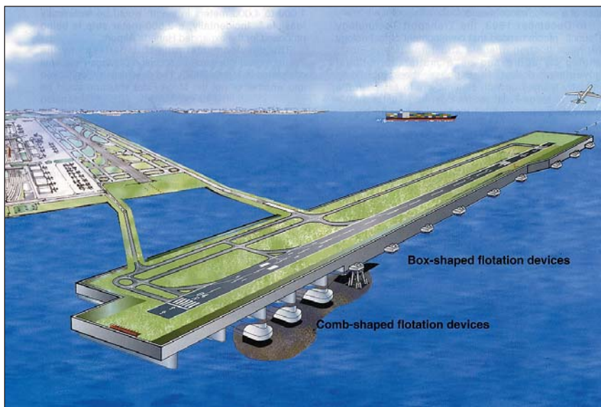
Проектный вариант плавучего аэродрома, созданного по технологии Mega-Float
