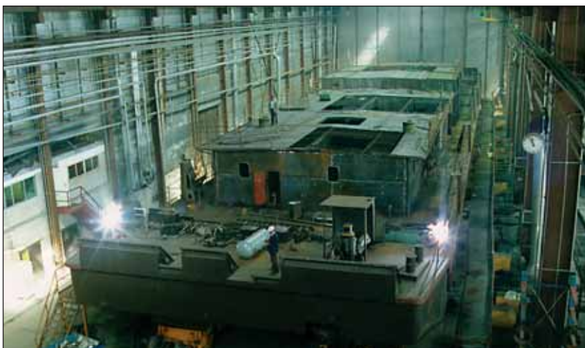
Постройка несамоходной станции комплексной переработки отходов пр. НСКПО/81108 в эллинге ОАО «Самусьский судостроительно-судоремонтный завод»
