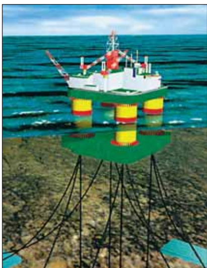
Проектное изображение буровой платформы на натяжных опорах типа ТЛР (ЦКБ МТ «Рубин»)
