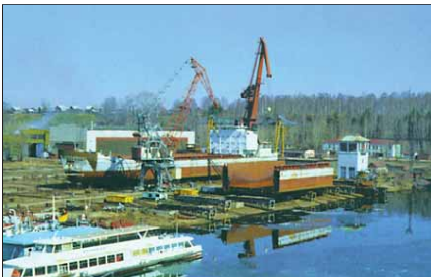
На слипе АО «Городецкий судоремонтно-механический завод»
