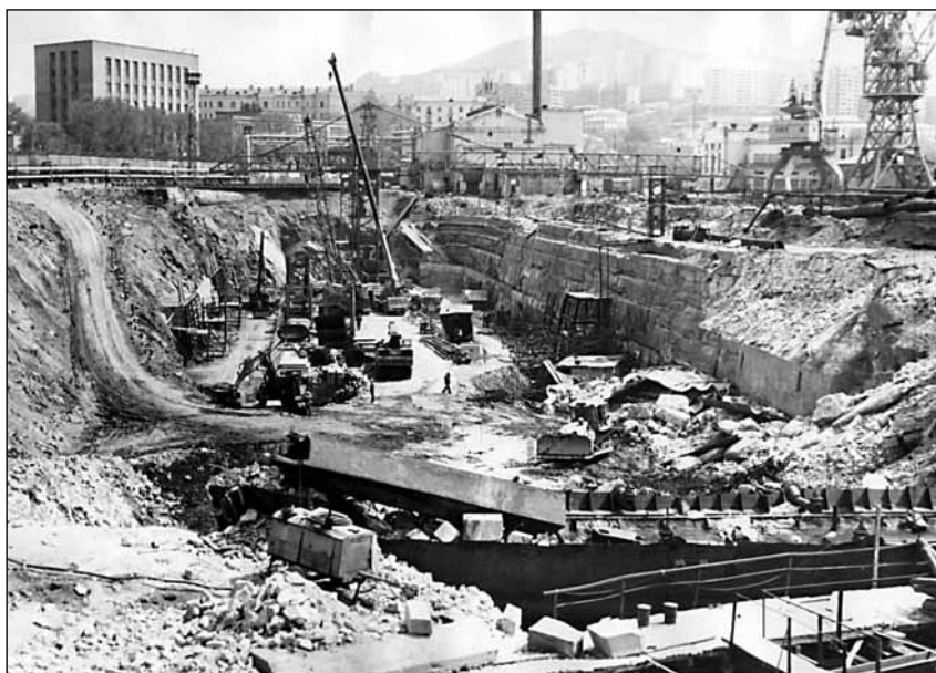
Рис. 3. Реконструкция дока № 2 на «Дальзаводе» (Владивосток)
