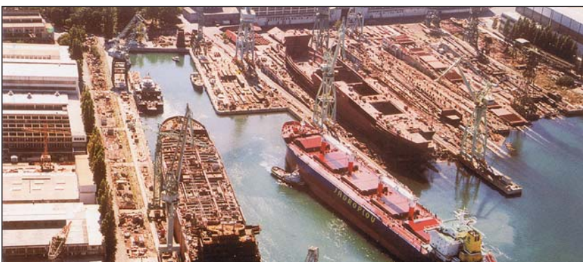
Панорама четырех наклонных стапелей верфи Brodosplit Shipyard
