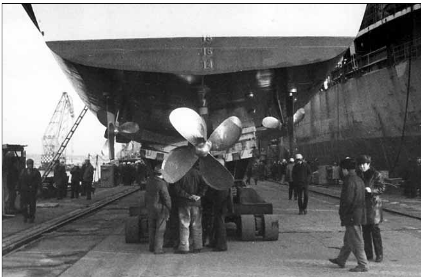
Рис. 3. Осмотр гребных винтов трехвального судна пр. 10110 перед спуском на воду
