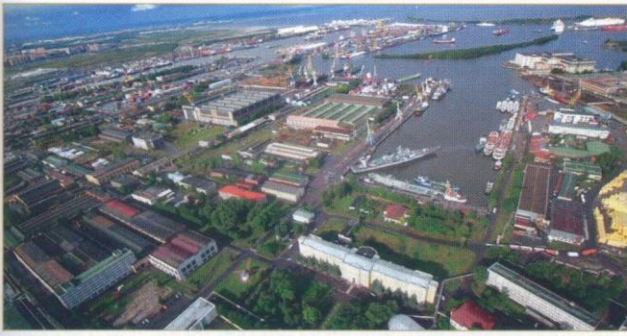
Концептуальным проектом, разработанным в АО «ЦТСС», предусмотрены мероприятия, которые позволят удлинить сухой док ОАО «Судостроительный завод «Северная верфь» до размера 420 x 68 метров без остановки производства
