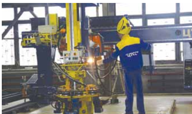
Установка ребра жесткости на микропанель
